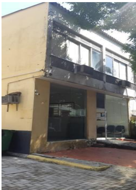
Imagem 98 - Prédio Alugado e anexo ao Instituto Educacional Carlos Gomes
